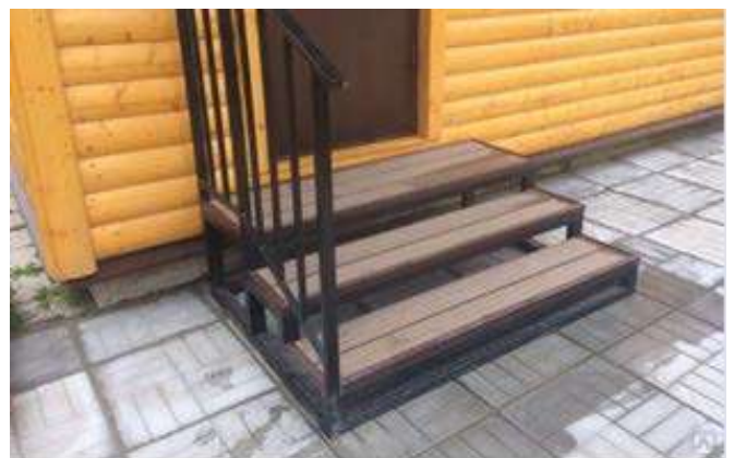
Рис. 16б. Крыльцо, не включаемое в контур здания
