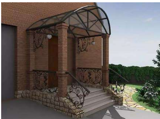
Рис. 16а. Крыльцо, включаемое в контур здания
