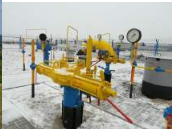
Рис. 33. Узел задвижек
