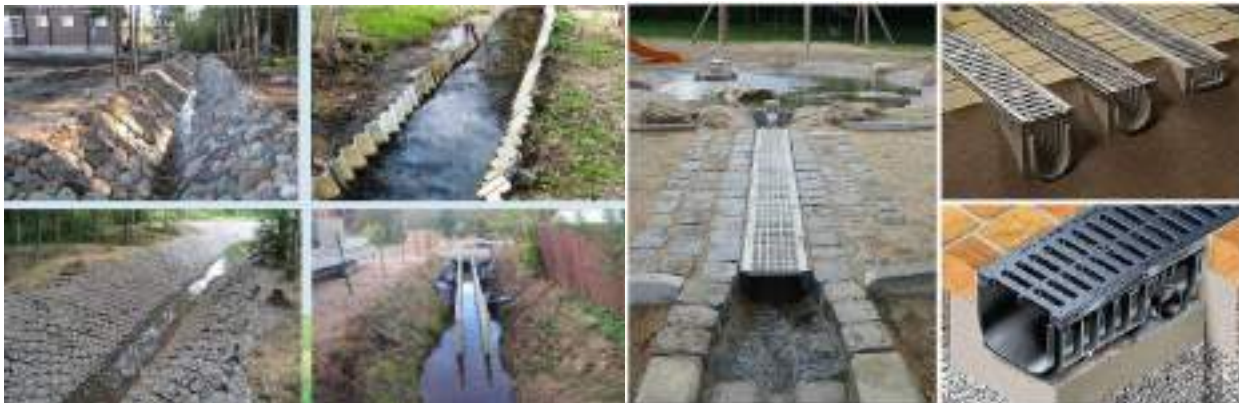
Рис.42. Открытые водоотводящие устройства
