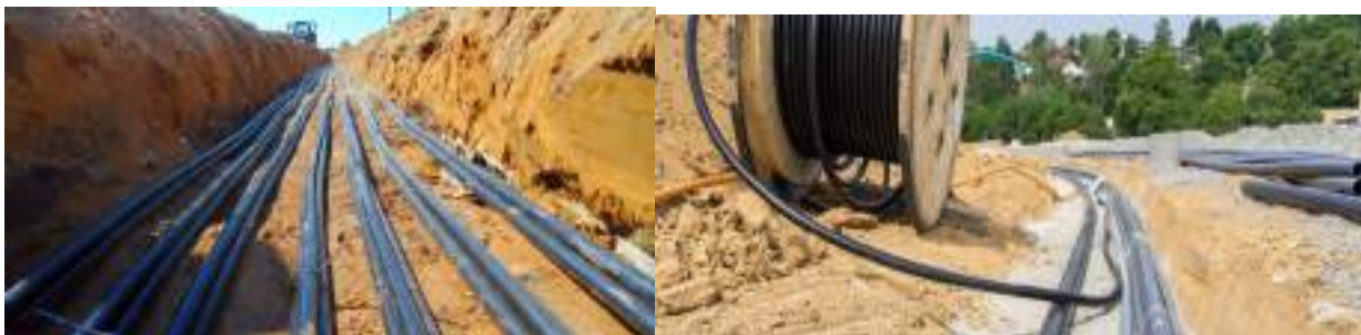
Рис.47. Траншейный способ укладки кабеля
