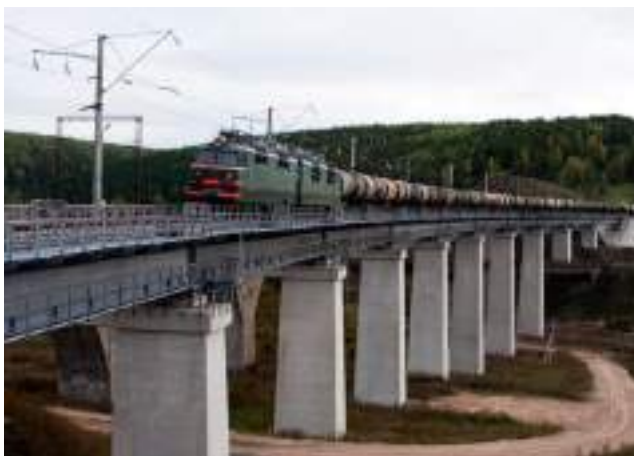
Рис. 16. Путепровод железнодорожного пути
