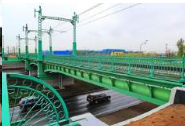
Рис. 17. Эстакада железнодорожного пути
